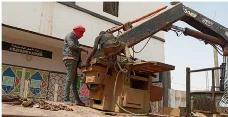
positionnement et levage de la lourde machine à bois.
