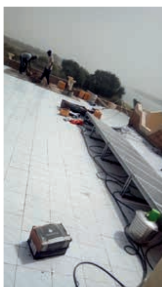
tegels leggen op het dak
