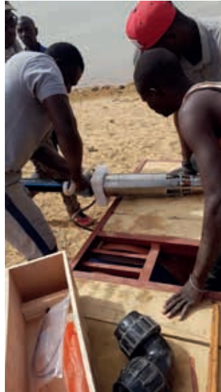
plaatsen van de pomp
